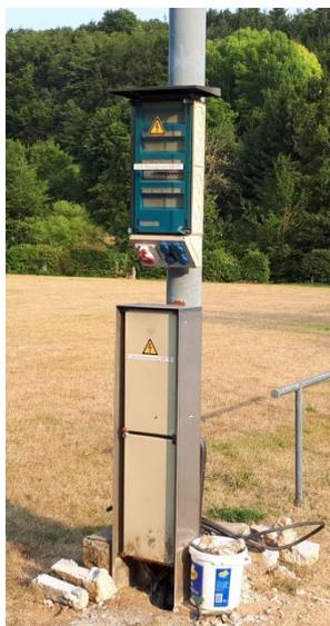
Der durch einen Erdnagel des Kirchweihzeltes abgetrennte **Stromverteiler** am Spielplatz wurde an den Lichtmast versetzt.
